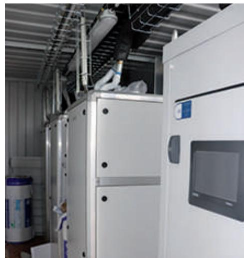
**Le container de 3 tonnes situé en toiture du bâtiment contient les trois unités thermodynamiques indépendantes et le module hydraulique équipé d'une armoire de régulation embarquée, placée en partie supérieure du module.**
